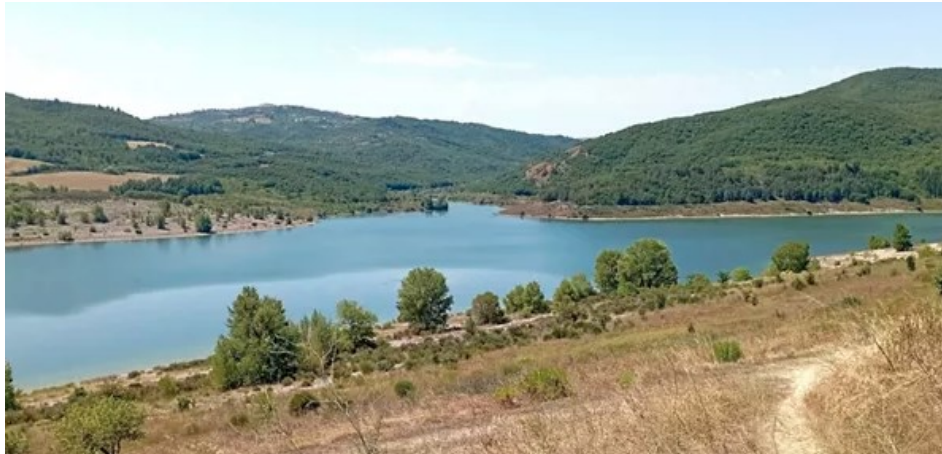
Figura 2. Diga di Acerenza
