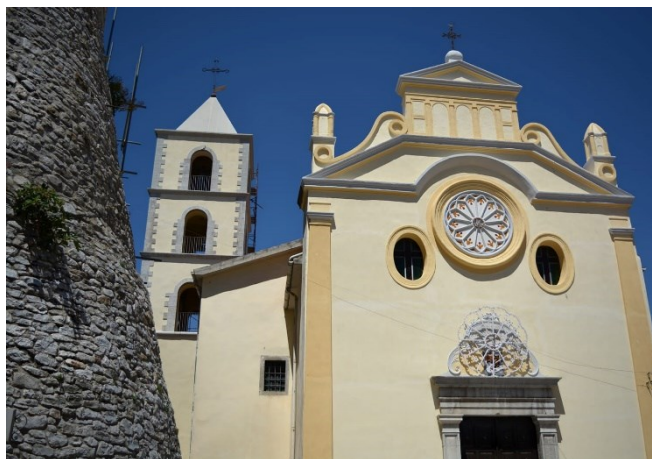
Figura 1. Chiesa Madre di Santa Maria del Carmine (Cancellara)
